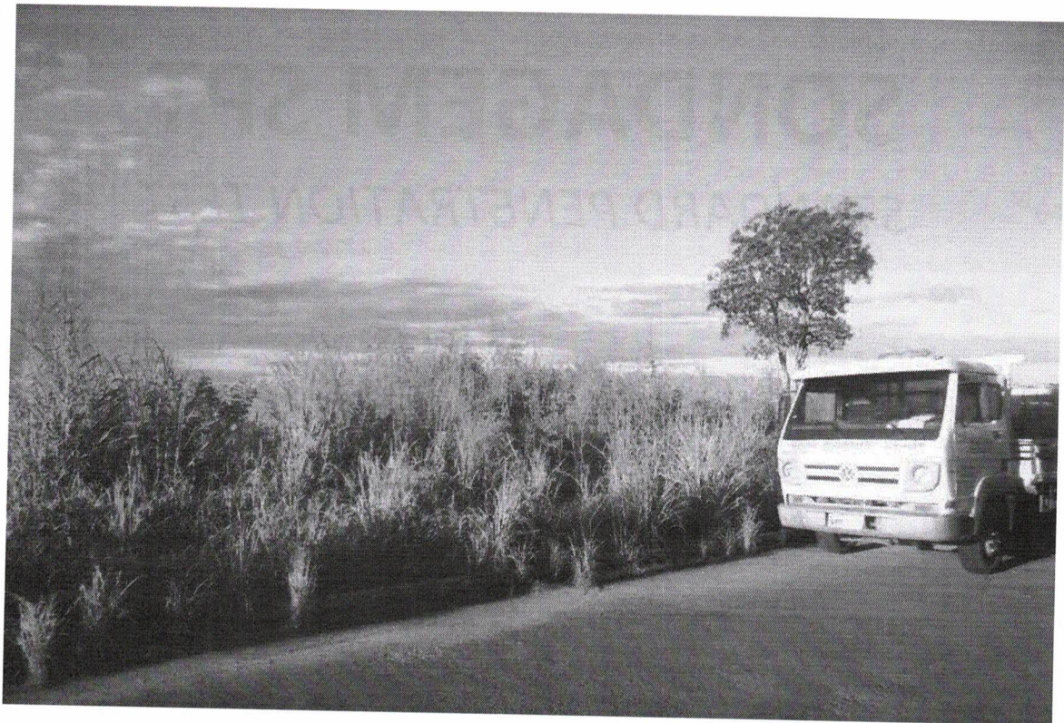
EXECUÇÃO DE SONDAGENS NO LOCAL
